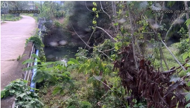
TC220512 : สะพานบ้านท่าคลอง ต.ทับปrik อ.เมืองกระบี่ จ.กระบี่
